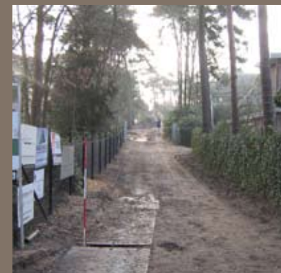
Oprit tijdens de bouw
